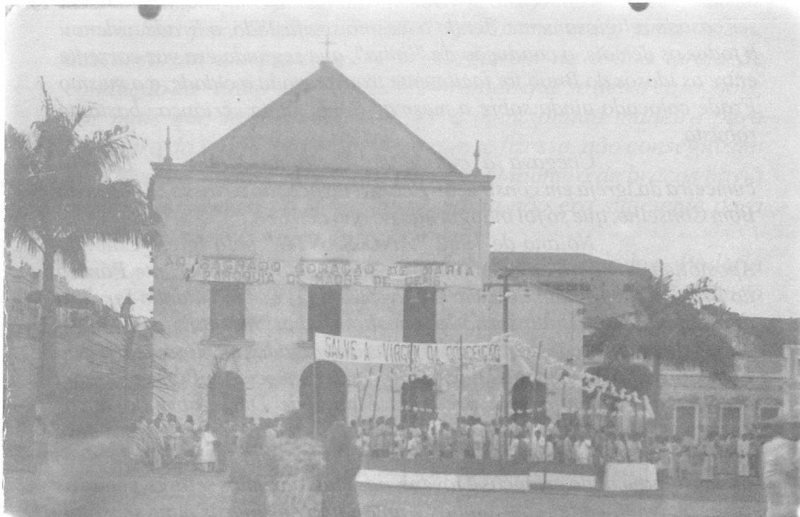
Foto da primitiva Capela de Nossa Senhora da Conceição, depois Nossa Senhora do Bom Conselho, no Brejo da Madre de Deus, cuja construção teve início no ano de 1865, e inaugurada no ano de 1868. A foto acima é de 1945. A pedra fundamental foi posta por Frei Caetano de Messina, em 1852.
